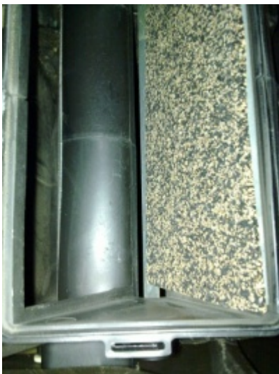
Abb. 3 : Mit Korkfolie beklebte Lüftungsklappe
